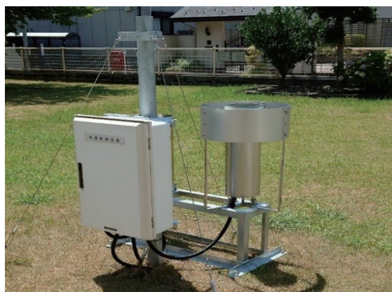
写真「降水検知付二層式雨量計」
