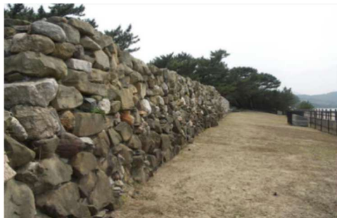
写真1.6 建治2(1276)年に博多湾の海岸線に築いた元寇防塁 「福岡市文化財情報」から
