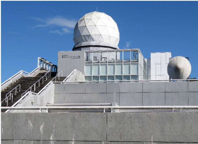
写真1.2 富士吉田市立富士山レーダードーム館
