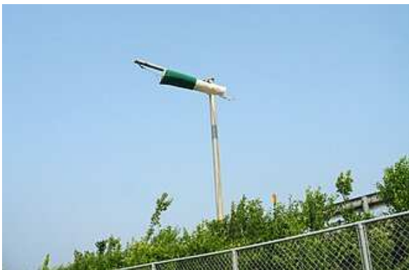
写真2 高速道路上に設置されている吹流し
