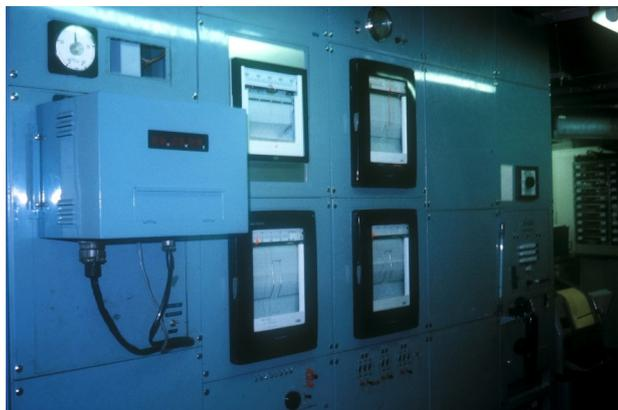
写真1. 富士山測候所に設置された気象テレメータ装置 (本田耕平氏提供)
